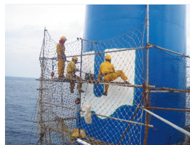
ファンネルマーク塗替作業
