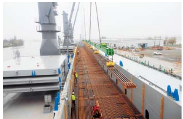
長尺レールの揚荷役状況
