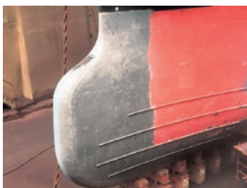
第五芙蓉丸 船底外板 旧塗膜剥離作業
