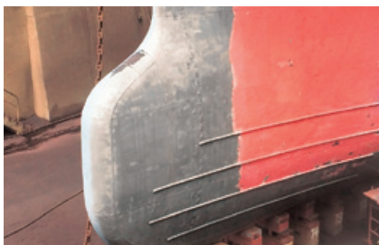
第五芙蓉丸 船底外板 旧塗膜剥離作業
