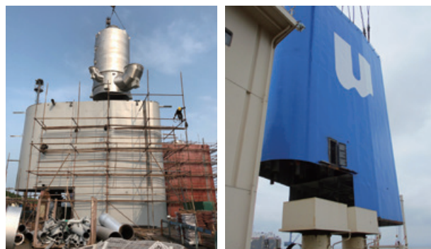
SOxスクラパー搭載工事
