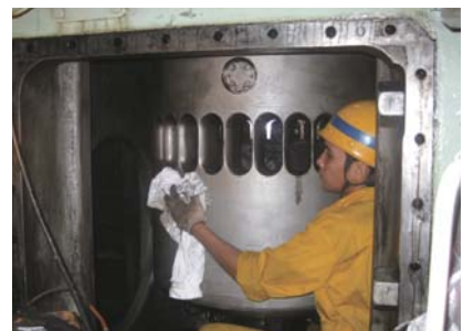
機関室での整備作業
