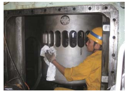
機関室での整備作業
