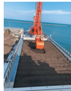
大容量グラブバケットによる場荷役
